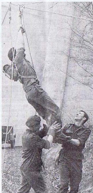
Suivre le corde et éviter le noeud... (Cliché « L'Avenir du Luxembourg ». Photo C.V.)
