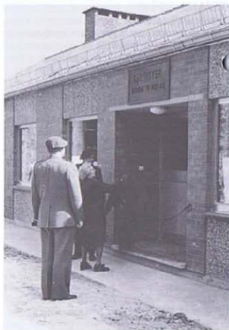
Plaque dévoilée par la sœur du Cpt Royer lors de l'inauguration du nouveau bloc au quartier Ratz.
