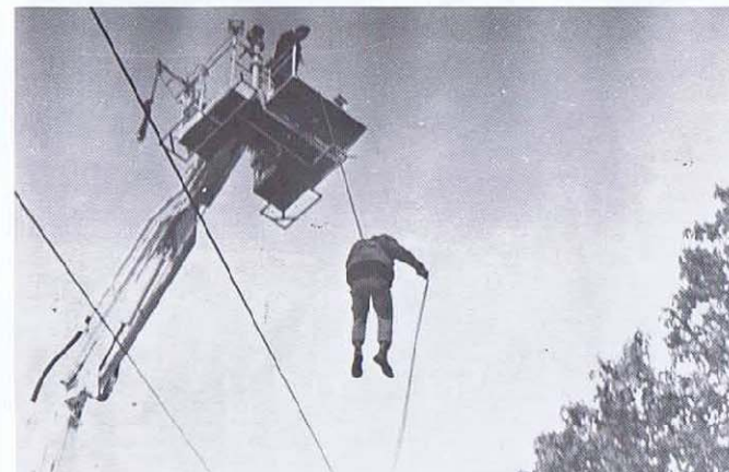
Du haut de l'échelle des pompiers 18 mètres.
