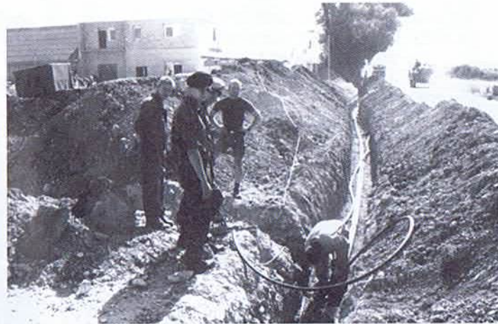
A gauche, vue générale du camp Green Field avant l'implantation du réfectoire et des cuisines. A droite, les tranchées d'aménagement des conduites d'eau en bordure de la route civile; elles vont faire de nos voisins d'heureux consommateurs d'eau potable. Ci-dessous à gauche: l'équipe de purification d'eau, à l'oeuvre sur Green Field; à droite: Le génie prépare le camp pour l'hiver: planchers, toitures et cloisons fermant les couloirs entre les containers.
