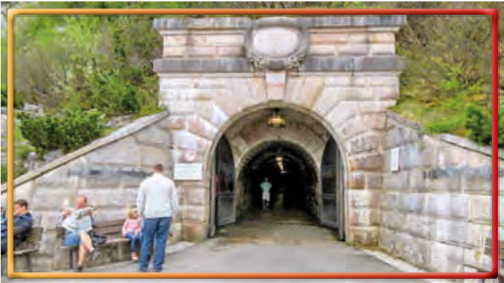
Un tunnel de 124 mètres creusé dans la roche et
